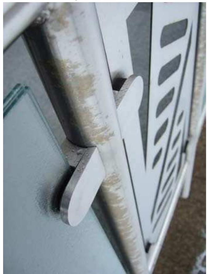
Bräunliche Verfleckungen wie diese lassen sich mit im Fachhandel erhältlichen Phosphorreinigern entfernen. Aber am besten lässt man es nicht so weit kommen, wie auf diesem Bild! (Quelle: M&T-Metallhandwerk)
